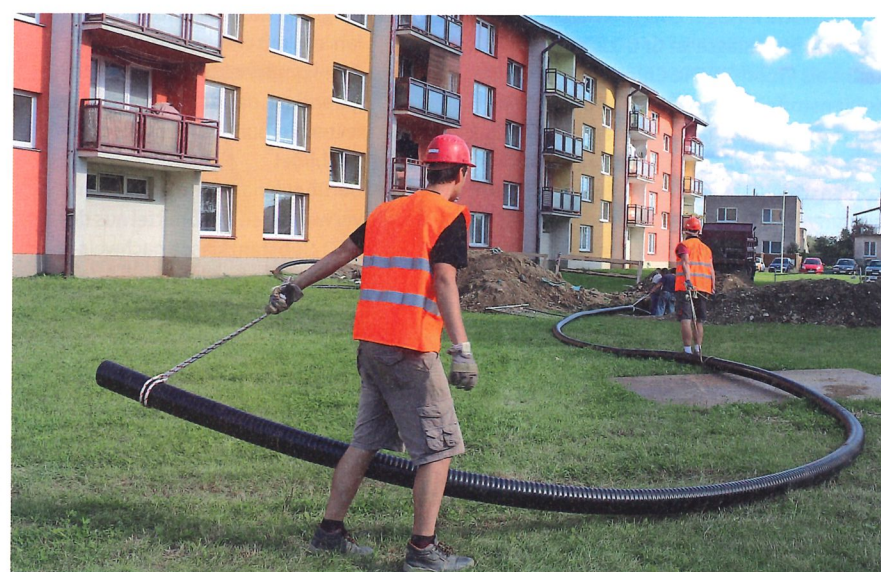
Flexible Rohrsysteme bestehen aus polymeren Mediumrohren (PMR), einer thermischen Dämmung und einem Aussenmantel aus Polyethylen. Das hat den Vorteil, dass lange Längen am Stück verlegt werden können.
