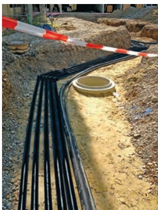
Verlegung im Graben
