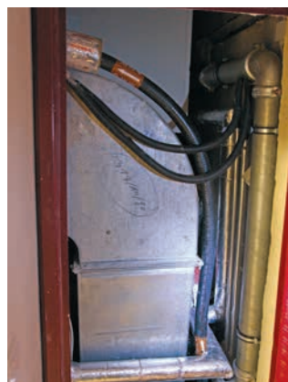
Trotz großer Enge im Gebäude: Verlegung in einem Stück
